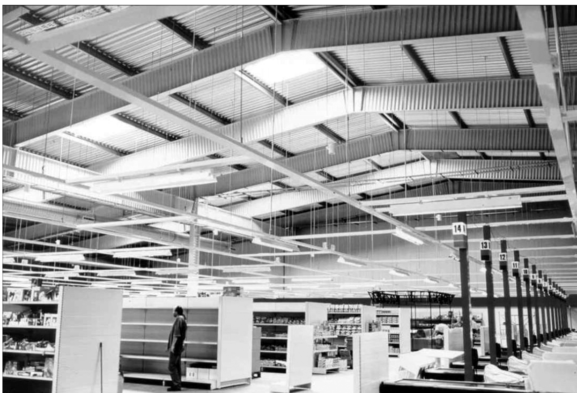
Рис. 1.8. Общий вид покрытия торгового центра с применением балок фирмы «Zeman» (Польша)
