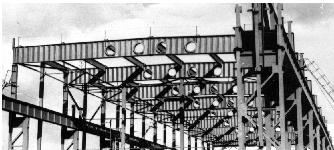
Рис. 3.1. Покрытие цеха в виде стропильных балок с гофрированной стенкой. Для пропуска систем вентиляции в стенках балок выполнены отверстия.
