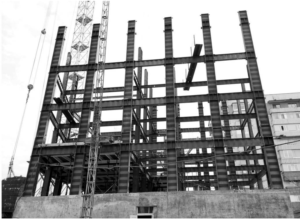
Рис. 1.7. Каркас девятиэтажного жилого дома в г. Алматы (Казахстан) в процессе строительства
