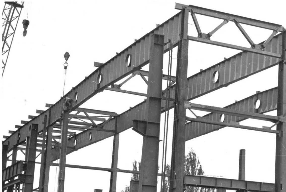
Рис. 1.5. Покрытие здания производственного корпуса завода 20 лет Октября в г. Алма-Ате (Казахстан). Фото предоставлено Ю.С. Максимовым
