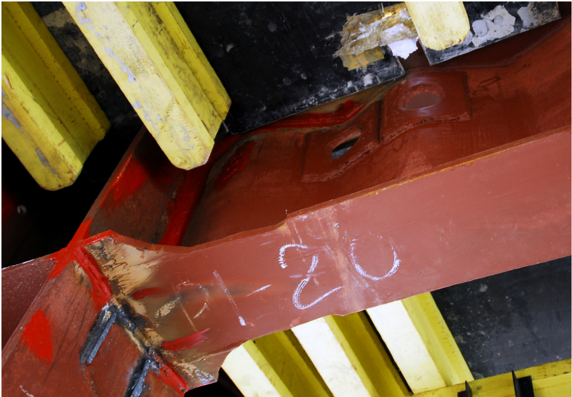
Рис. 3.2. Балка перекрытия многоэтажного жилого здания в г. Алматы, Казахстан. Для пропуска коммуникаций в стенке балки выполнены отверстия.
