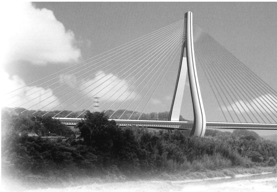
Рис. 1.4. Общий вид подвесного моста «Yahagigawa bridge» (Япония)
